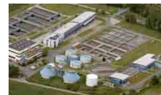
Vom Schmutz- zum Reinwasser, Kläranlage Kamen-Körnebach
